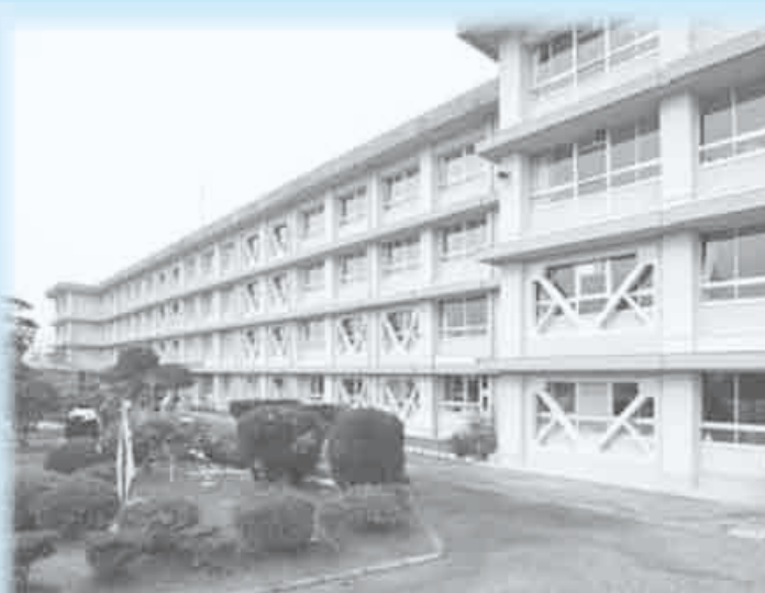
耐震化実施後の 十日市小学校
