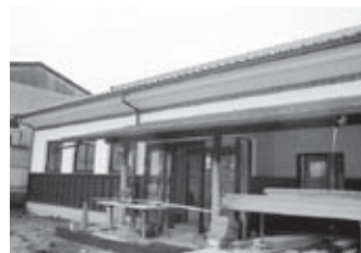
建設中の布野図書館
