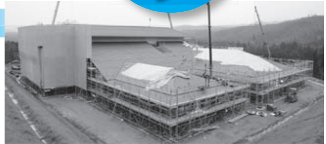
建設工事の様子(12月22日現在)
