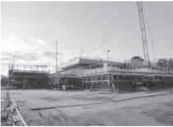
11月1日現在(左側が新斎場の正面)
